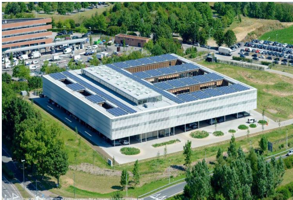
900 枚のソーラーパネルを導入し、ニアリー ゼロ・エネルギービルディング実現した ベルギー本社
