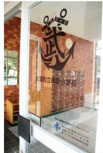
武豊小学校の校章をデザインした校舎正面玄関の防災ガラス
