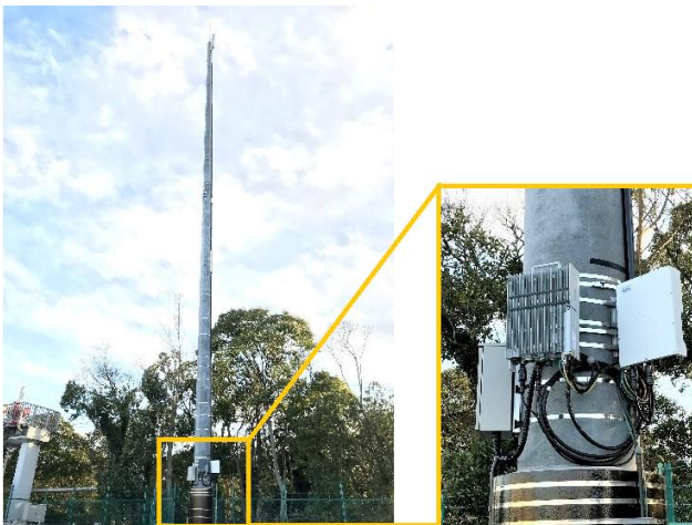
千葉工場内をカバーする自営等BWAの基地局 地上高約30mのアンテナ塔と無線局端末装置
